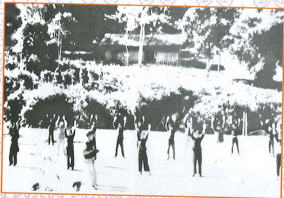
Học sinh trường cấp III Bắc Kạn tại điểm trường sơ tán, năm 1964 - 1968
