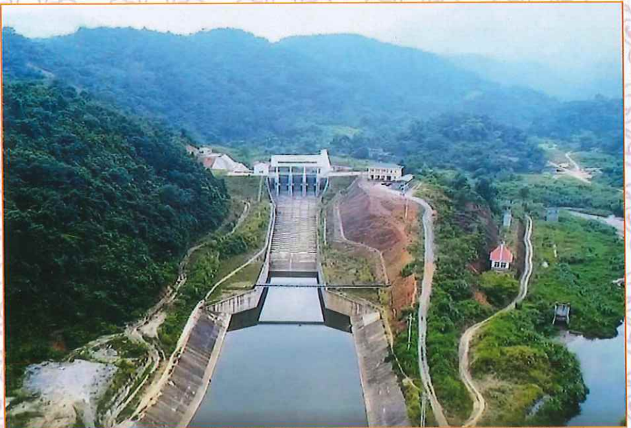
Đập tràn hồ Năm Cắt
