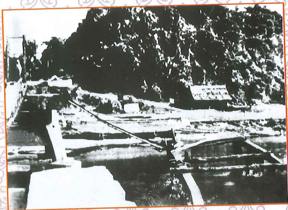
Nhân dân thị xã Bắc Kạn phá cầu, đường để chống thực dân Pháp, năm 1947
