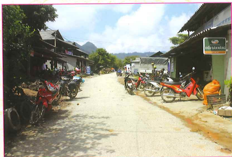
Hệ thống đường giao thông từ xã Bằng Phúc đi trung tâm huyện Chợ Đồn đã được rải nhựa
