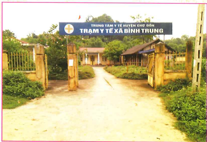
Trạm Y tế xã Bình Trung
