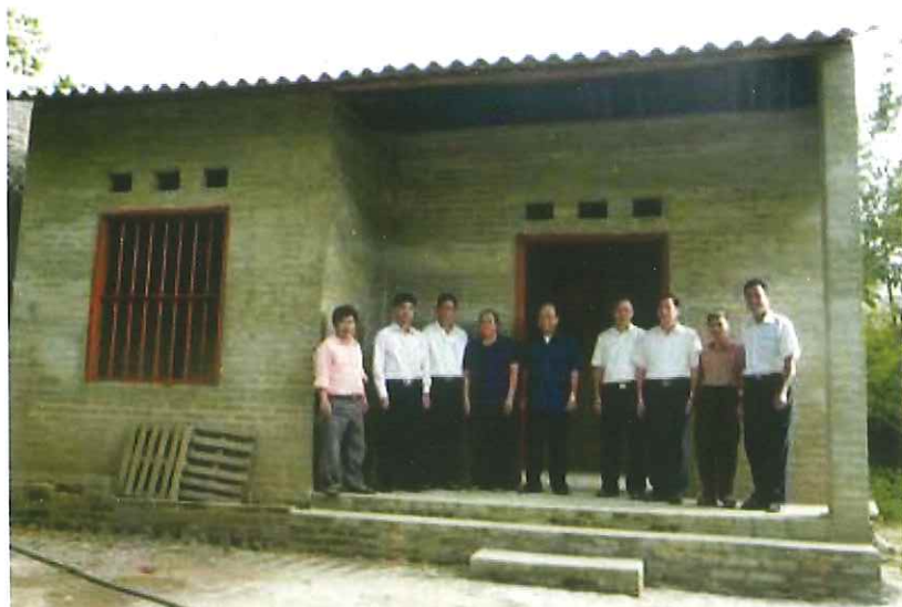
Nhà mẫu thí điểm xây dựng bằng gạch không nung tại thôn Bản Phố, xã Cao Kỳ
