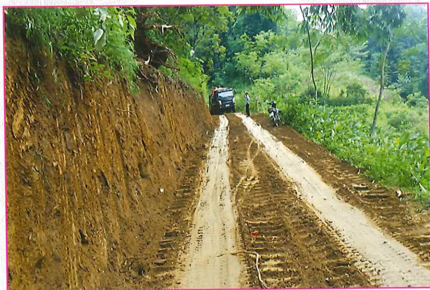
Thi công xây dựng đường liên xã Cổ Linh - Bộc Bố (được hoàn thiện năm 2004)
