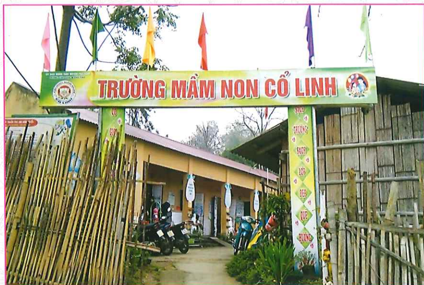
Trường Mầm non Cổ Linh (xây dựng năm 1989)
