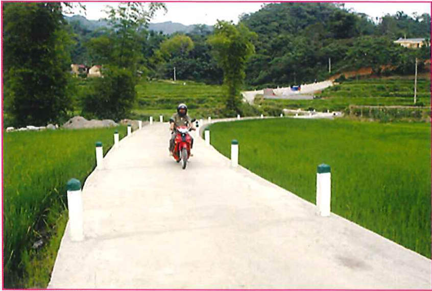
Đoạn đường được bê tông hóa hoàn thiện năm 2014
