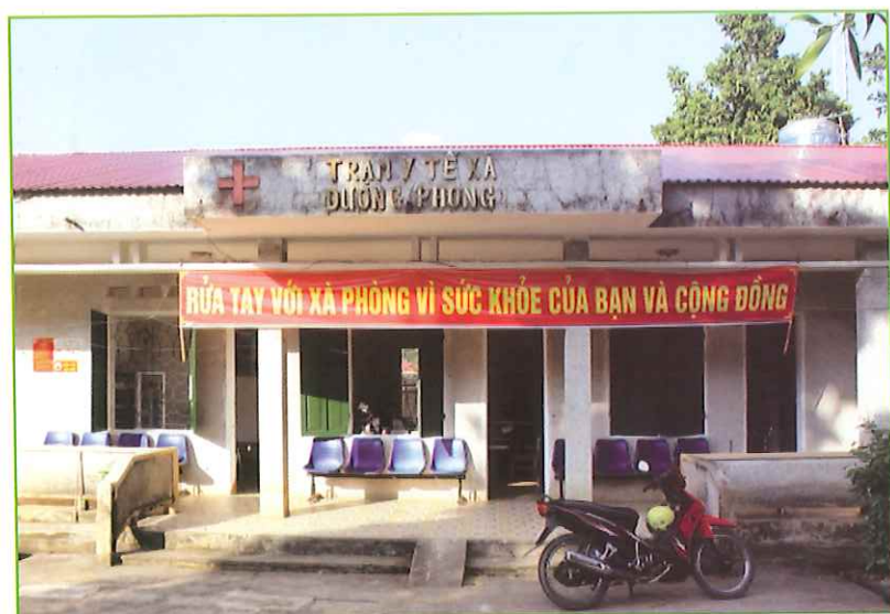
Trạm Y tế xã Dương Phong
