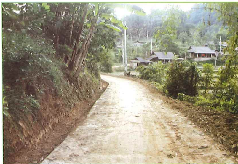
Đường giao thông liên thôn được bê tông hoá
