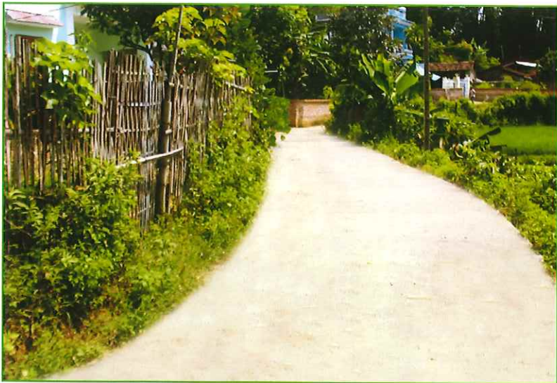
Đường giao thông nông thôn mới xã Hà Vĩ
