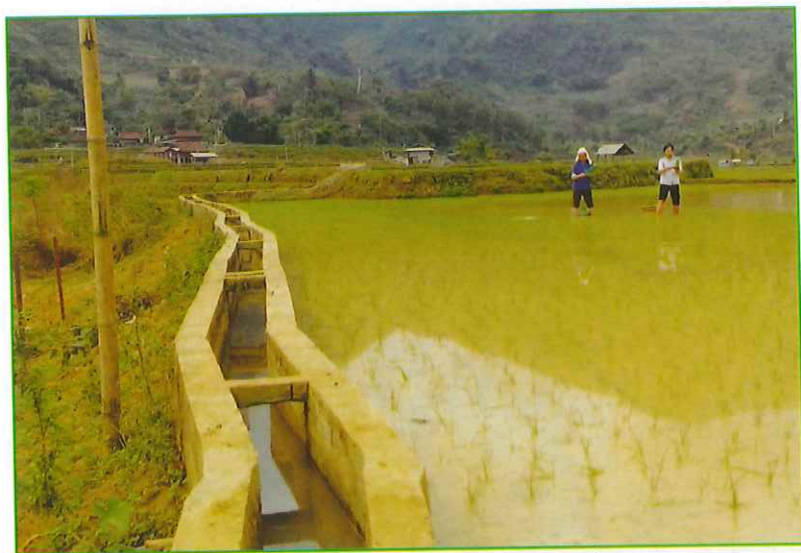
Kênh mương xã Hoàng Trĩ được kiên cố hóa
