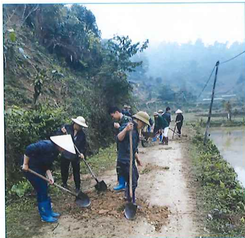
Đoàn Thanh niên xã Kim Hỷ sửa chữa đường giao thông liên thôn
