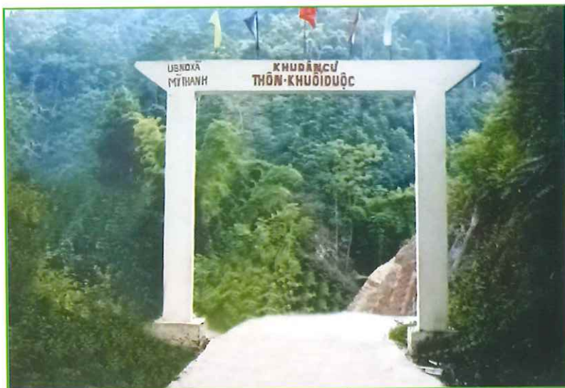
Đường giao thông nông thôn ở thôn Khuổi Duộc được bê tông hóa với vật liệu do Nhà nước hỗ trợ và người dân hiến đất, đóng góp ngày công
