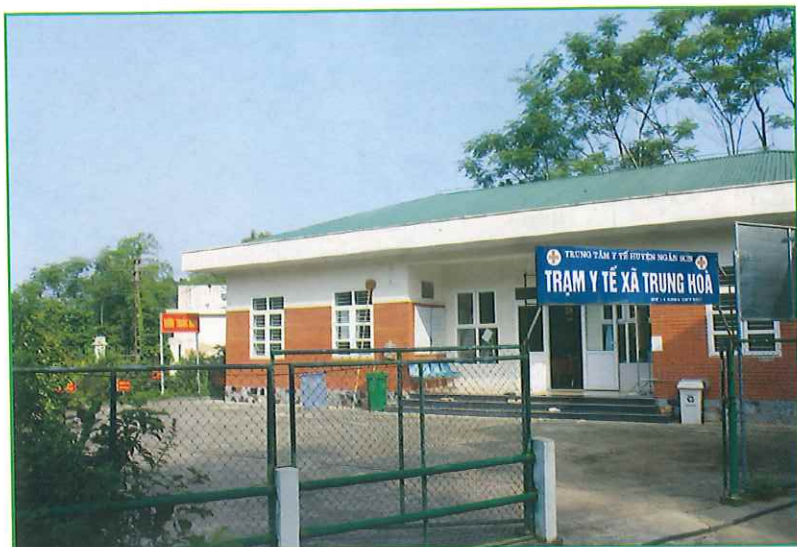
Trạm Y tế xã Trung Hòa
