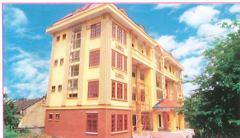
Công sở Đảng ủy - HĐND - UBND thị trấn Đại Từ mới đang hoàn thiện
