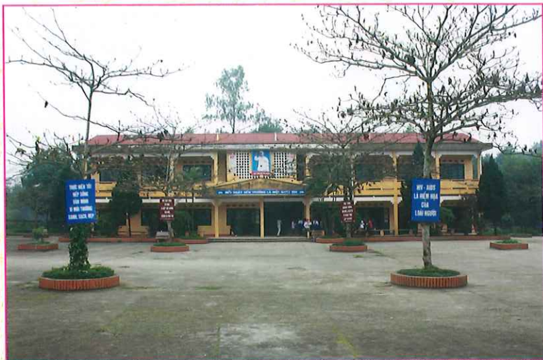
Trường Trung học cơ sở xã Hoàng Nông xây dựng năm 2001
