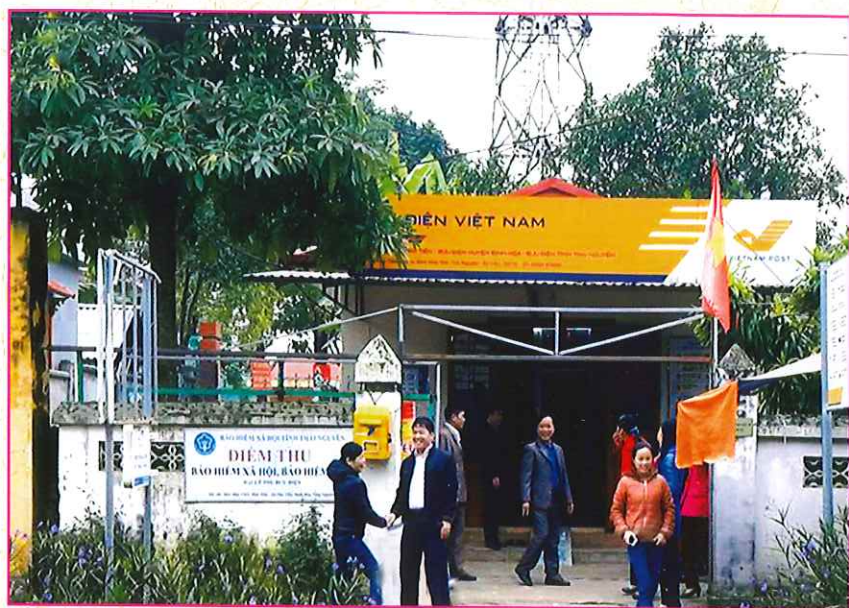
Điểm Bưu điện xã Phú Tiến (ảnh chụp năm 2016)
