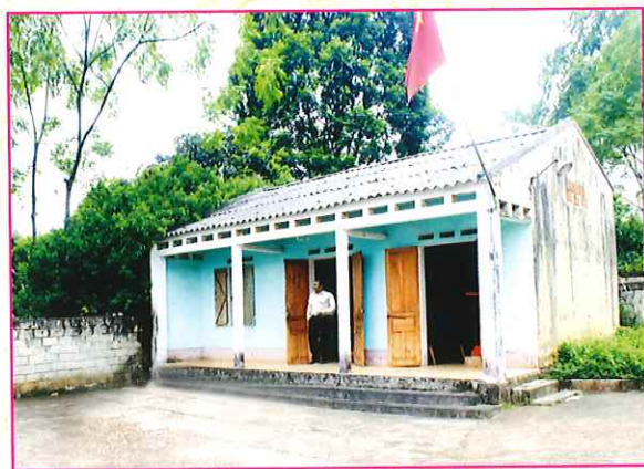
Nhà văn hóa xóm Ao Sen - được xây dựng đầu tiên trên địa bàn xã (năm 2001)
