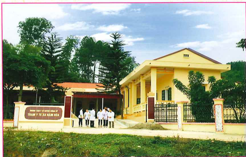
Trạm y tế xã Nam Hòa (xã đạt chuẩn quốc gia về y tế năm 2009)
