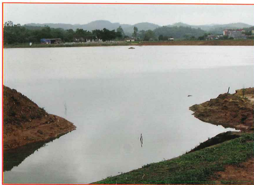
Công trình đập nước thủy lợi xóm Quấn xã Tân Đức
