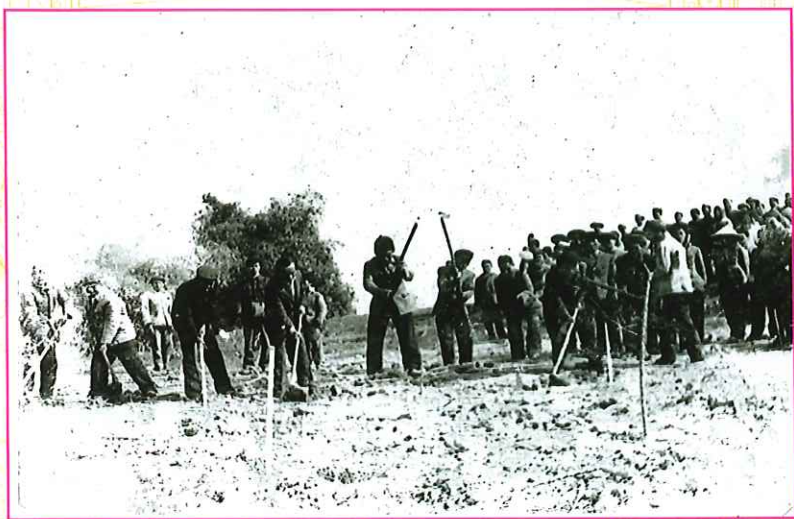
Lễ khởi công xây dựng công trình điện và trạm bơm ở HTX Liên Sơn, xã Sơn Cẩm ngày 10 tháng 1 năm 1984
