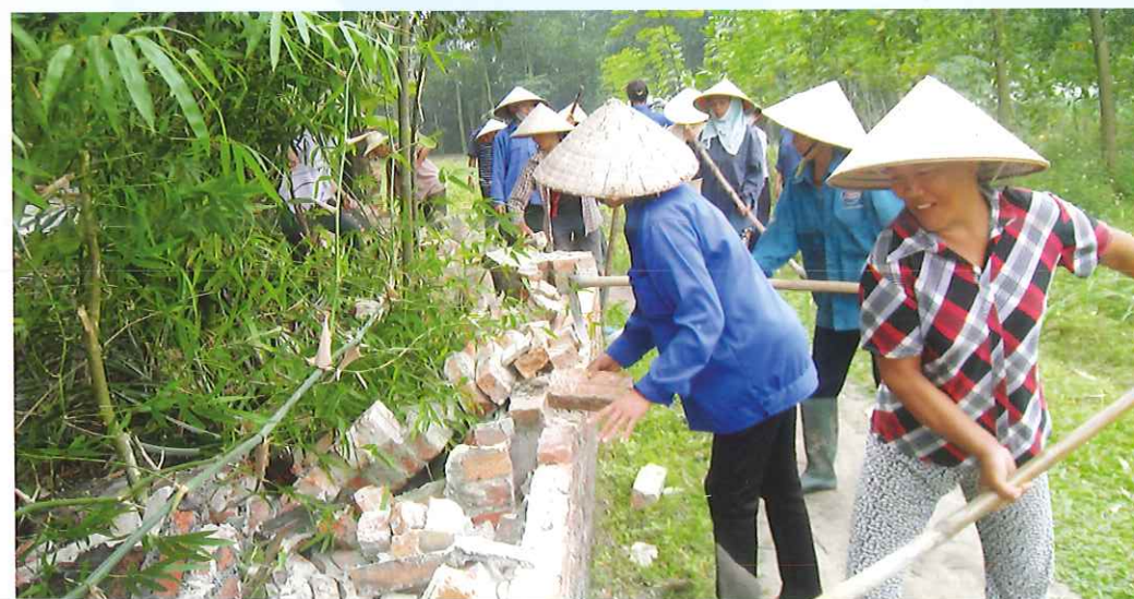
Nhiều hộ dân tự tháo dỡ công trình để hiến đất làm đường.
