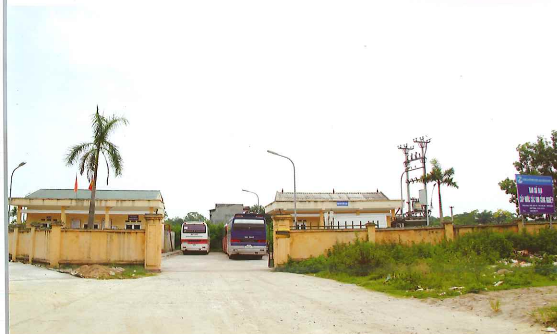
Trạm cấp nước các khu công nghiệp Phổ Yên.
